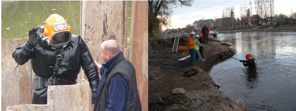
Jedlik híd Győr - segédjárom vágás
