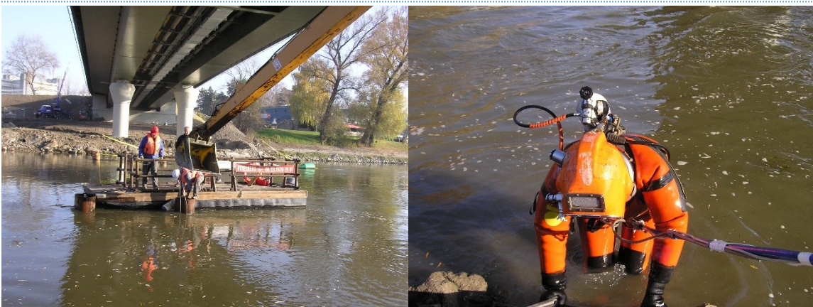
Jedlik híd Győr - kötözési munkálatok kiemeléshez
