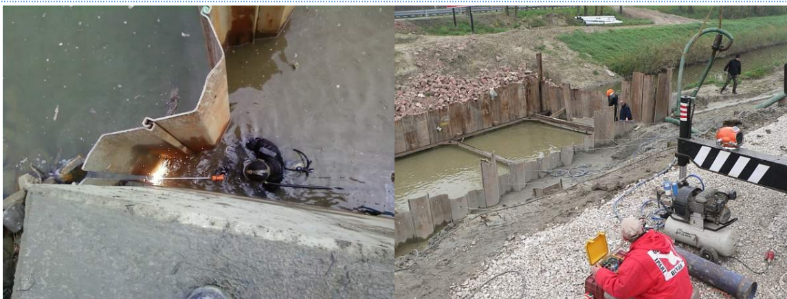
Pándzsa-Győr zsalu műtárgyépítés
